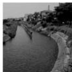
芝生大橋の導水路
